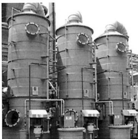
Figura 11 – Lavador de gases tipo torre de pratos ( http://www.belfano.com.br ).
