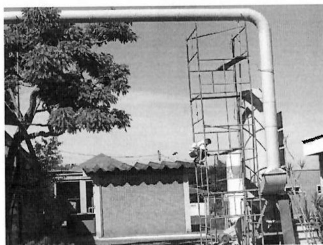
Figura 27 – Montagem do lavador de gases vertical.
